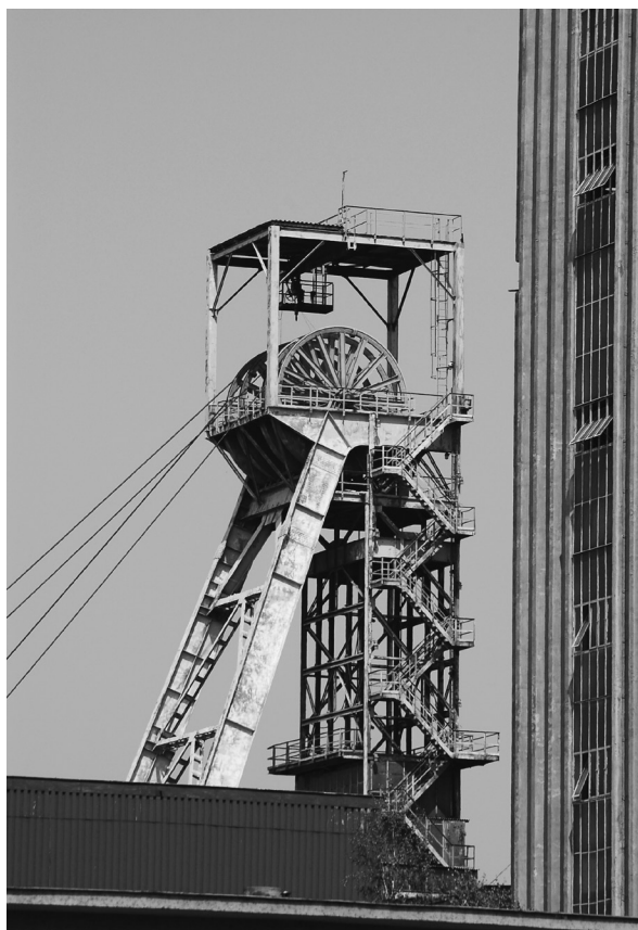
Těžní věž důlního Závodu 3, bývalého Závodu Důl Paskov. foto archiv OKD
